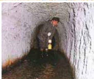
写真-1 羽場のずい道内部
