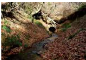
写真-2 羽場のずい道出口
