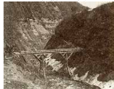
昭和10年頃の橋
