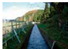
花崗岩露頭近くにあり、川井橋付近の川井堰より取水されています
