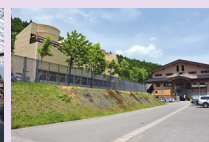
上の岱地熱発電所
