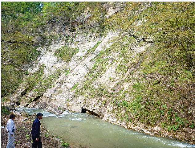
三途川峡谷付近の隧道取水口
