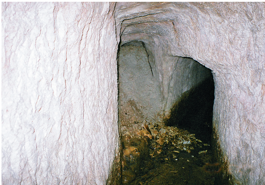
羽場の隧道内の様子
